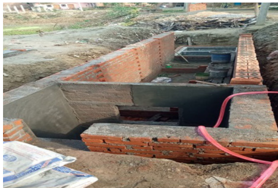
インドのウッタール・プラデシュ州に設置した排水処理システムの建設中の様子 WaterAid / Archana Pandey
